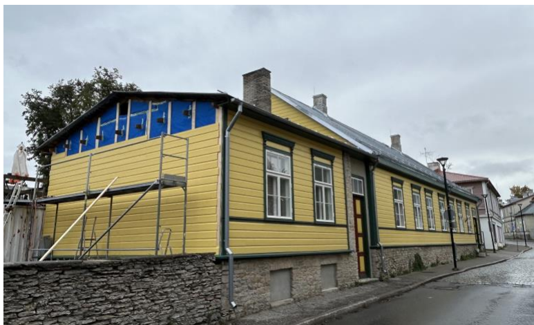
Tööd ajaloolise pastoraadihoone renoveerimisel jätkuvad.
