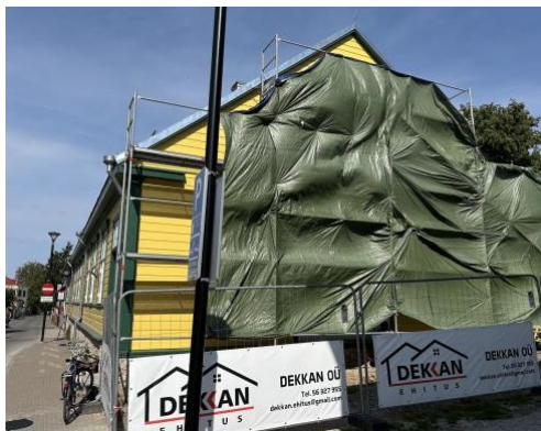
Ajaloolise pastoraadihoone remont jätkub.
