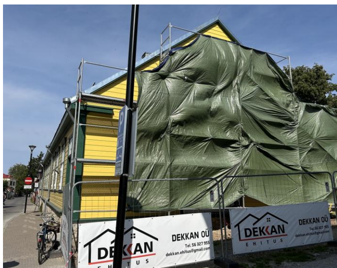
Tööd ajaloolise pastoraadihoone renoveerimisel jätkuvad.
