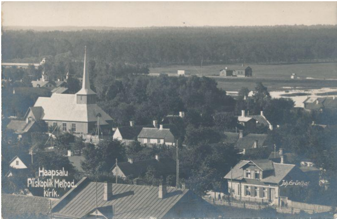
Vaade Haapsalu metodisti kirikule piiskopilinnuse tornist. Foto: Joh. Grünthal, 1930. aastate teine pool. SALM kogu
